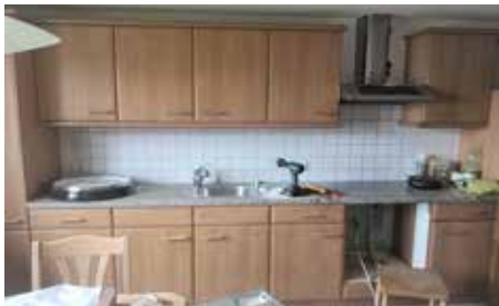
Arbeiten im Küchenbereich
